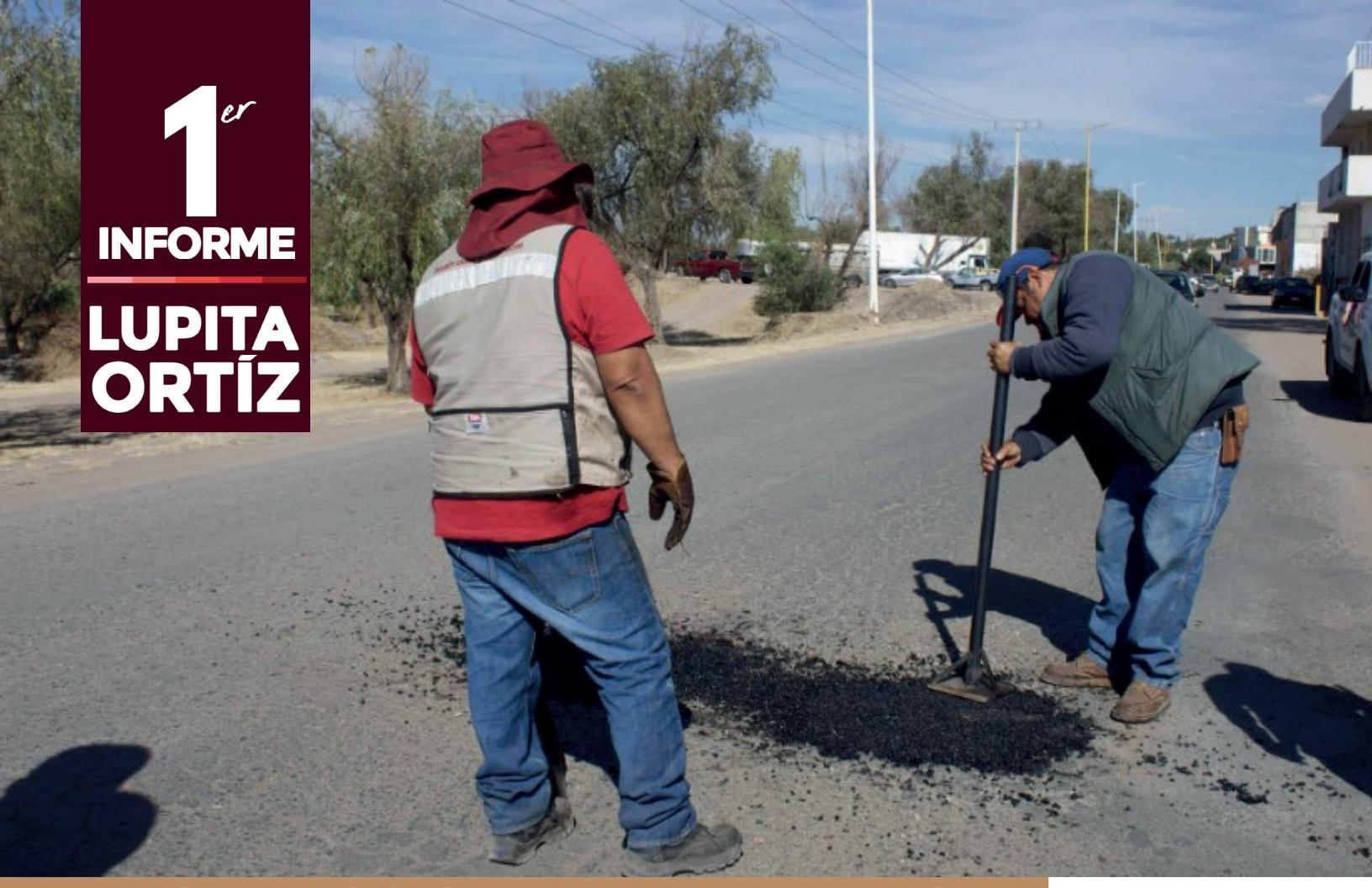
**En la comunidad Lobatos se apoyó con acciones de bacheo en calles donde se realizaron trabajos de reparación de fugas en la red de agua potable.**
